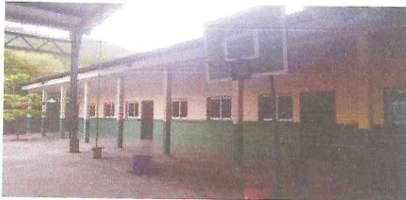
Foto 3: Sustitución de pintura interior y exterior 3 aulas y corredor
