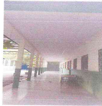
Foto 2: Sustitución de cielo falso en mal estado en el corredor
