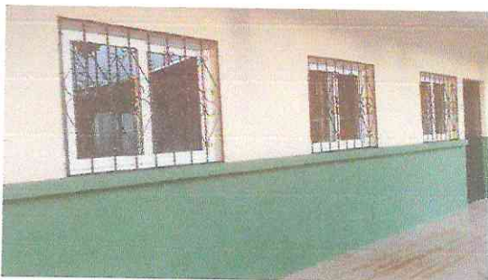
Foto 5: sustitución de ventanas de metal por PVC
