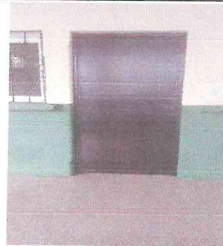
Foto 4: sustitución de pintura de puerta salon tres
