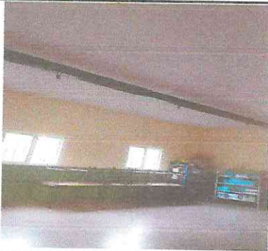
Foto1: Sustitución de cielo falso en mal estado aula 3.
